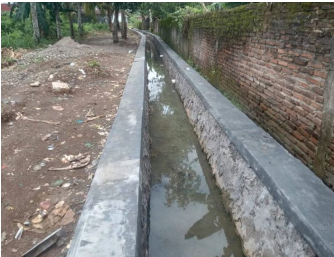
Pembangunan Saluran Drainase di Desa Sukamaju Kecamatan Labuan Tepatnya di Perumahan Griya Asri Labuan
